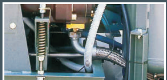
Systém automatického napínania remeňa (AM 37/90 kW). Pre riadny a trvalý chod remeňov.
